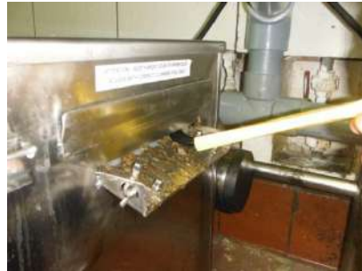
12 CON EL CEPILLO LIPIAR ORIFICIO DE SALIDA DE GRASA
